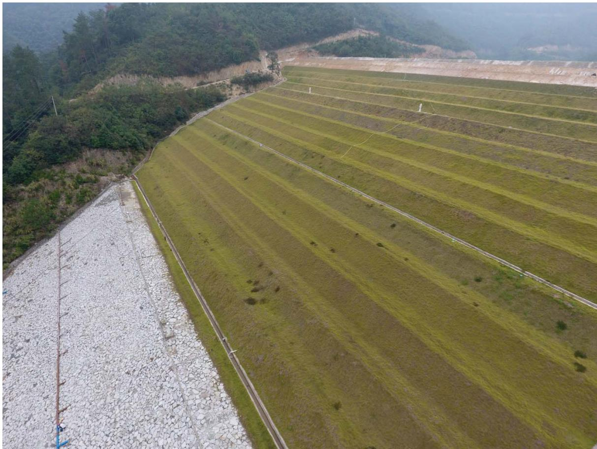
尾矿堆积坝 设置台阶，坡面植草护坡，设置平台沟、排水沟
